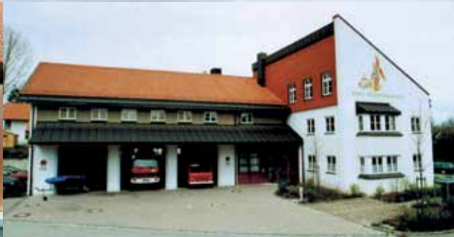
Finsings Feuerwehrgerätehaus seit 1995
