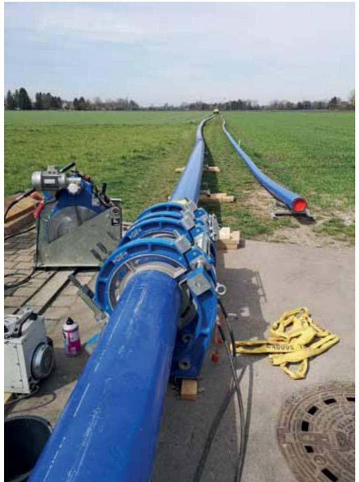
Um das Schutzrohr zusammenschweißen, wurde die volle Länge des Feldweges in der Verlängerung des Traberweges ausgenutzt.
