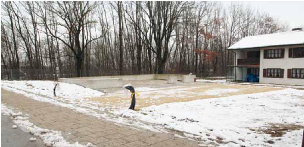
Zufahrt und Grundfläche sind schon gut sichtbar. (Fotos: GE)
