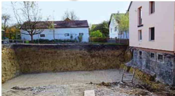
Die Bauarbeiten sind schon in vollem Gange und lassen die Größe bereits erkennen. Fotos : Sabine Drexler
