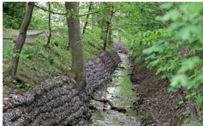
Nachher - das Bachbett wurde teilweise um über einen Meter versetzt. Die Baumwurzeln haben nun wieder Halt.
