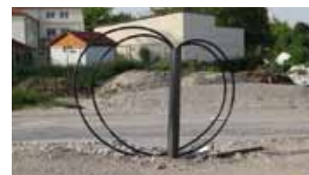
Die Stromkabel an der neuen Bayernwerkstraße grüßen schon herzlich die künftigen Nachbarn.
