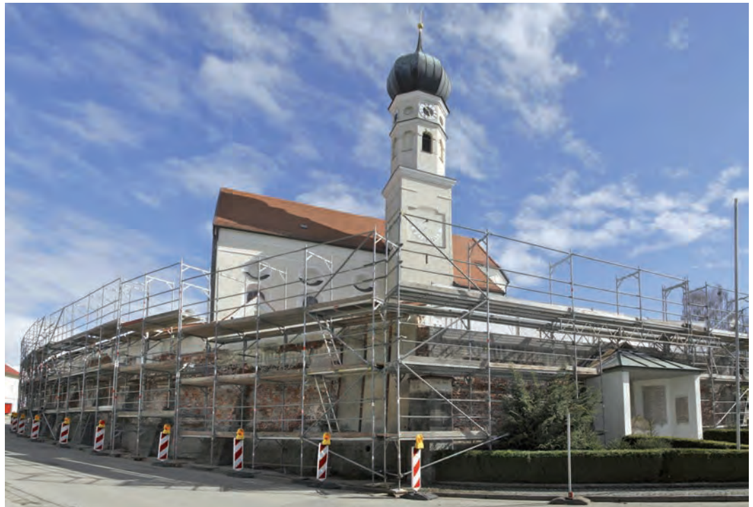
Ein Gerüst deckt das über 6 Meter hohe und 80 Meter lange Bauwerk ab. Bereits letztes Jahr wurde ein Teil des bestehenden Putzes abgeschlagen. So konnte das Mauerwerk austrocknen. (Foto F.X. Peischl)
