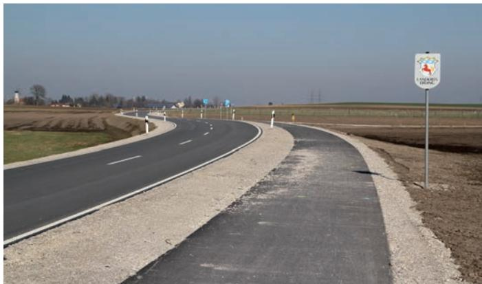
Doch damit ist bald Schluss. Im Sommer wird die Kreisstraße ED 11 saniert. Der Strukturausschuss des Landkreises Erding hat (gemeinsam mit dem Straßenbauamt Freising) während einer Ortsbesichtigung im Mai 2010 den Ausbau beschlossen. Auf der Strecke von Finsing bis zur Landkreisgrenze wird die Fahrbahn um einen halben Meter auf 6,50 Meter verbreitert. Die bislang engen Kurven werden ebenfalls verbreitert und somit etwas abgeflacht.
