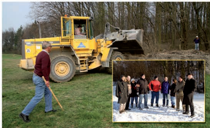
Schweres Gerät im Einsatz am „Ort des Geschehens“
