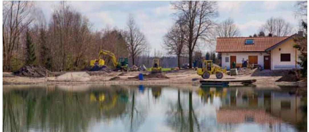
Der Eingriff in die Uferkontur ist deutlich: Tiefen- und Höhenverlauf werden maschinell verändert. Fotos: FXP
